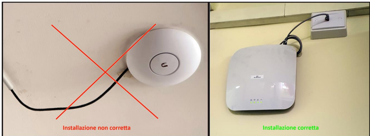
Figura 10 – Installazione corretta dell'Access Point
